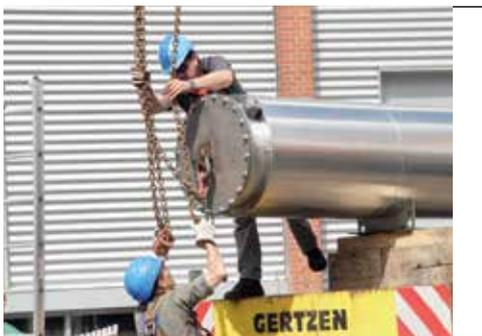
Verankert: Die bis zu 25 Meter langen Abgasrohre des neuen Blockheizkraftwerks
