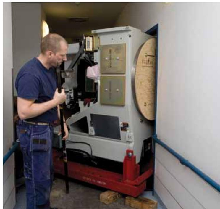
Das Hauptelement des Linearbeschleunigers wiegt 4,5 Tonnen und wird hier zentimeterweise um eine Kurve bugsiert
