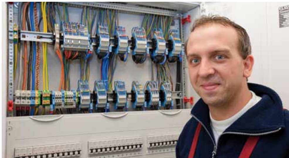
Die Stark- und Schwachstromanlagen in den Geschossen 4 bis 6 wurden erneuert. Elektriker Steffen Dittrich prüft den Schaltkasten der Starkstromanlagen
