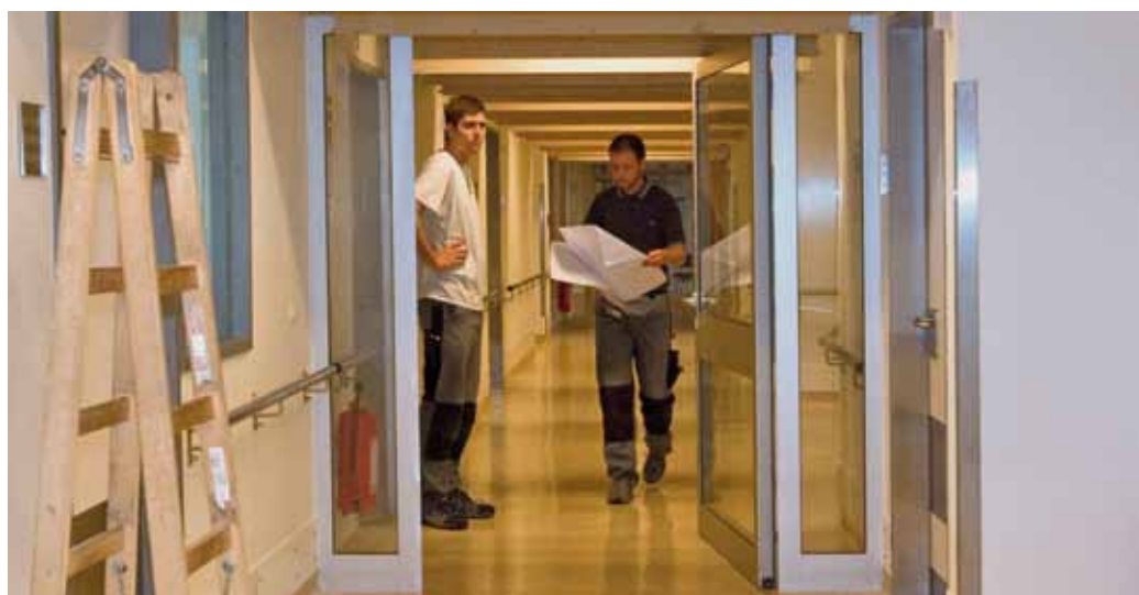
Während auf den Fluren noch die letzten Arbeiten verrichtet werden (o.), baut Peter Eichstädt bereits Cardio-Trainingsgeräte für die Patienten auf (l.)
