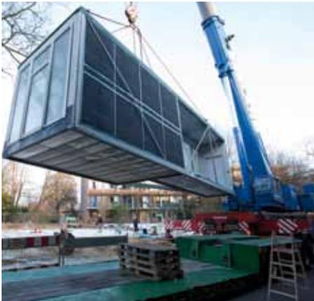
Haus am Haken: ein Fertigbaumodul für das neue Stiftungsgebäude
