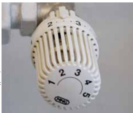
Mit Thermostatventilen am Heizkörper lassen sich Räume konstant auf einer Temperatur halten. Kühlt das Zimmer ab, öffnet sich das Ventil, ist es warm genug, schließt es sich.
