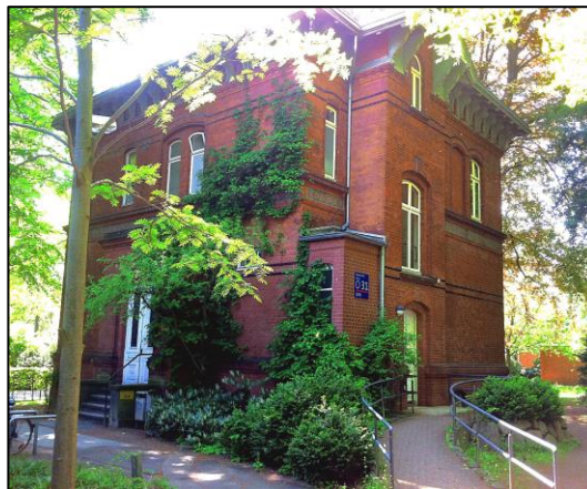
Außenansicht der „Villa Garbrecht“ in Blickrichtung Martinistraße
